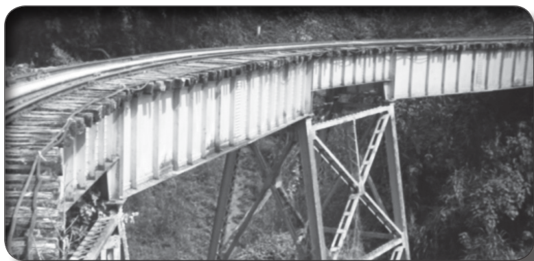
IMAGEN 14 VIADUCTO DEL FERROCARRIL DE AMAGÁ
