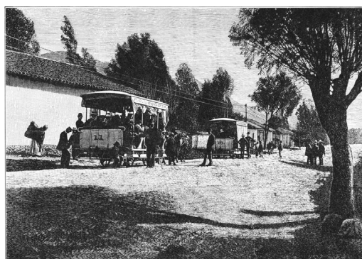
IMAGEN 9 PUNTO DE ARRANQUE EN CHAPINERO
