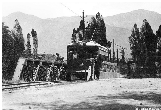
IMAGEN 32 LÍNEA AL BARRIO BELÉN
