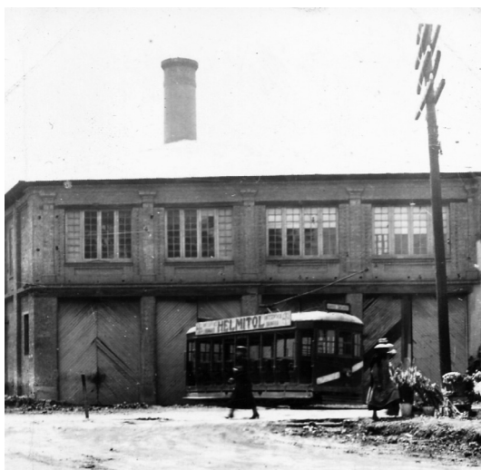
IMAGEN 13 ESTACIÓN DEL TRANVÍA EN LA CALLE 26 CON CARACAS
