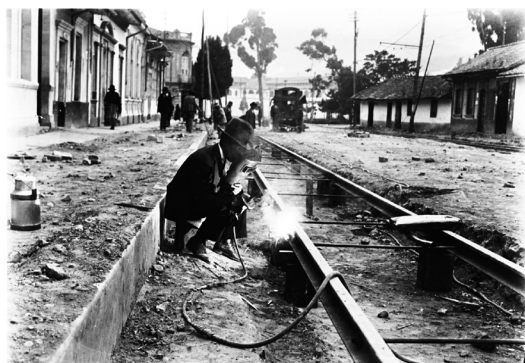
IMAGEN 17 TENDIDO DE LAS VÍAS DEL TRANVÍA (1910)
