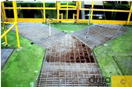
Figura 40 Rejillas corroída
