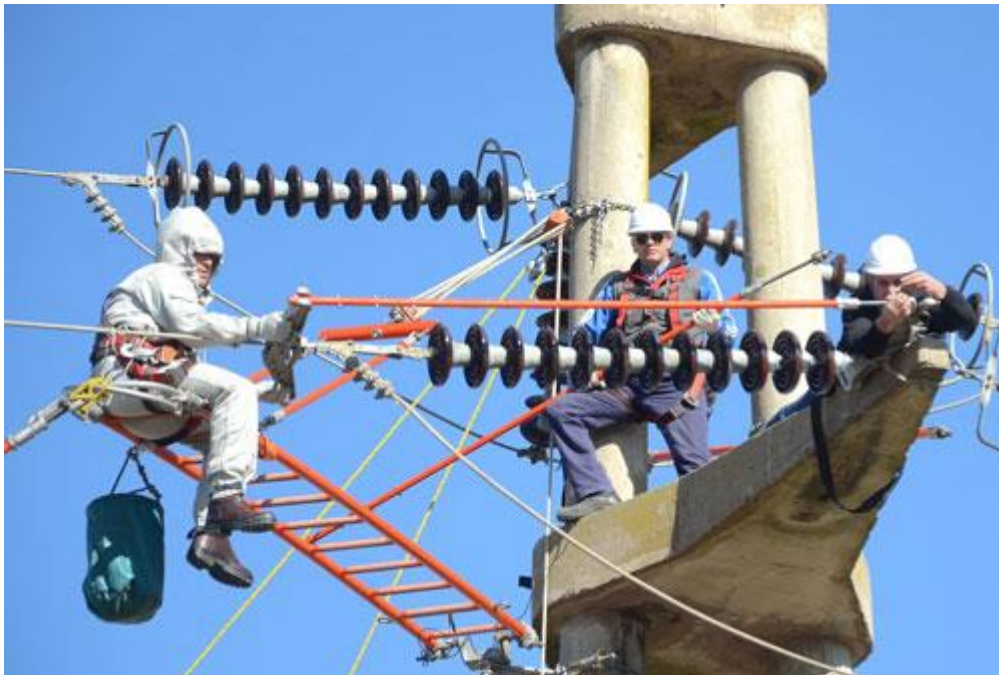
Figura 34 trabajo sobre línea de alta tensión
