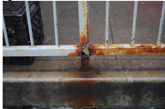
Figura 41 Baranda corroída
