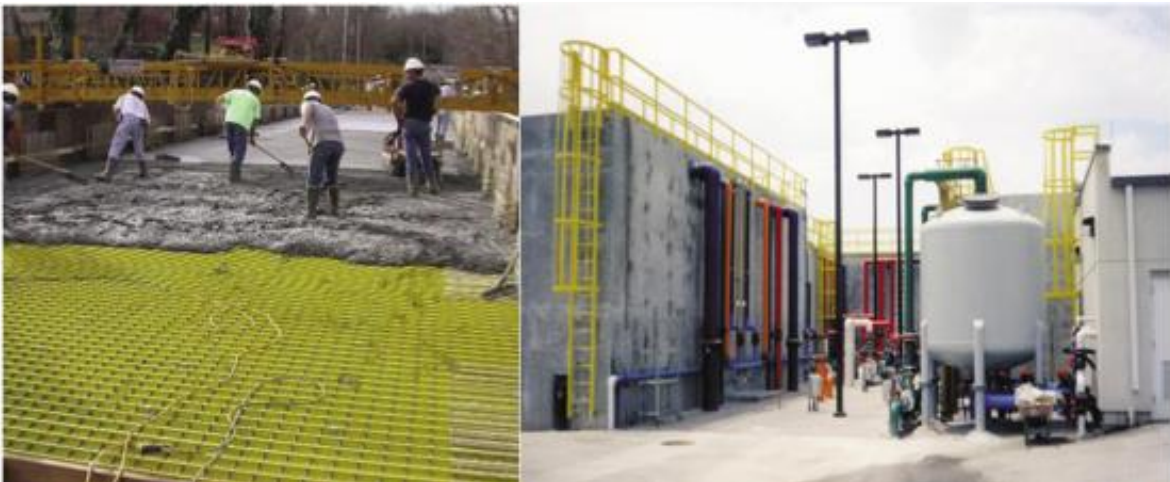
Figura 32 PRFV aplicado en construcción
