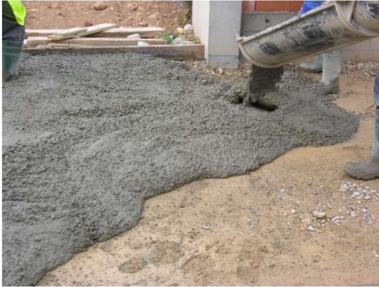
Figura 8 mezcla de material compuesto. Fundición de concreto
